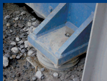
Dettaglio supporto antivibrante
